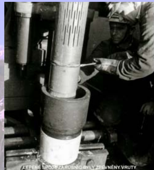
LEPENÉ SPOJE ZARUBNIC BYLY ZPEVNĚNÝ VRTY
