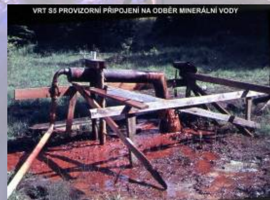
VRT S5 PROVIZORNÍ PŘIPOJENÍ NA ODBĚR MINERÁLNÍ VODY
